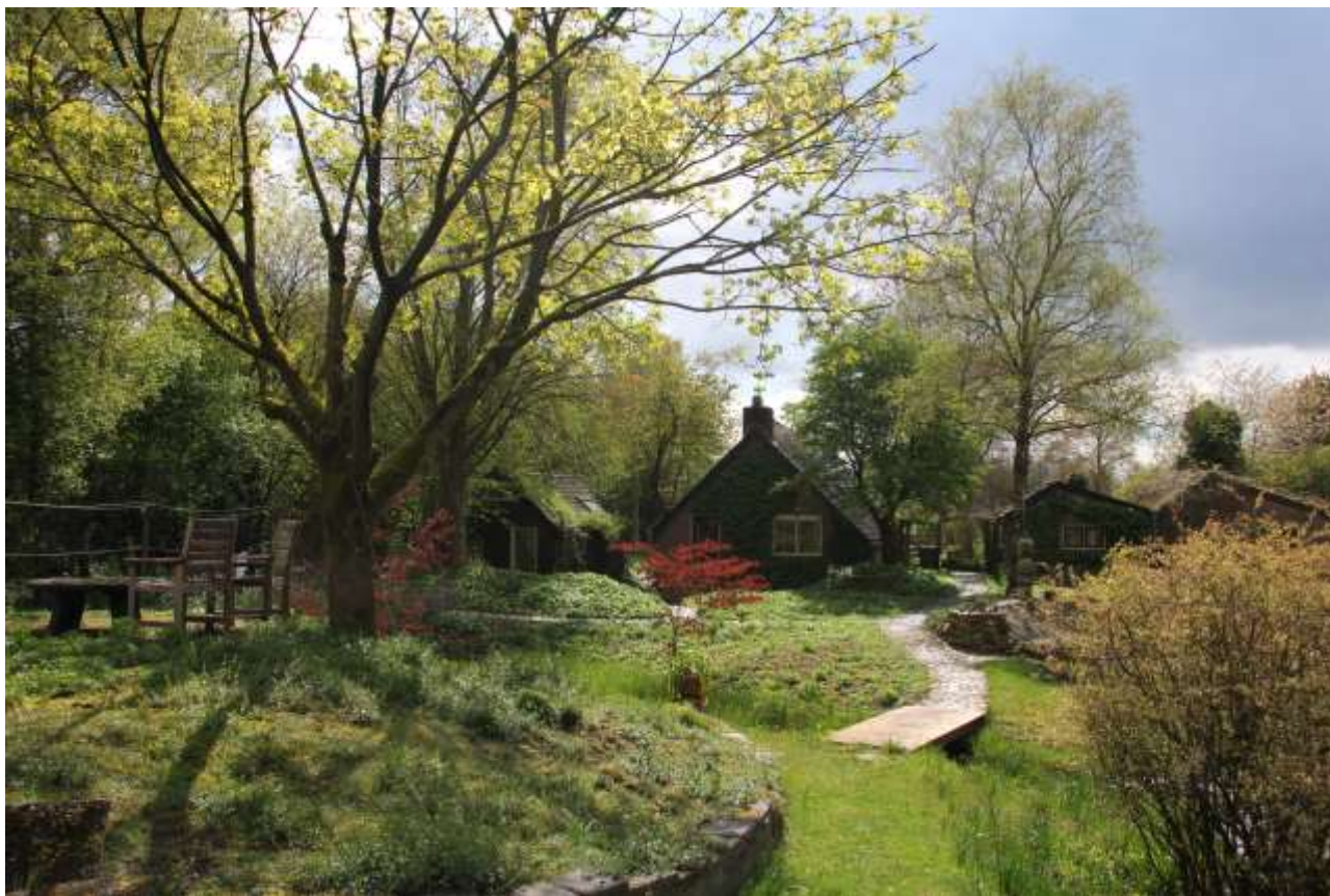
De gebouwen in Schepping, gezien vanaf de noordkant: het atelier (links), het woonhuis (midden) en de voormalige stallen, nu in gebruik als kantoor en werkruimte (rechts) (april 2017).
