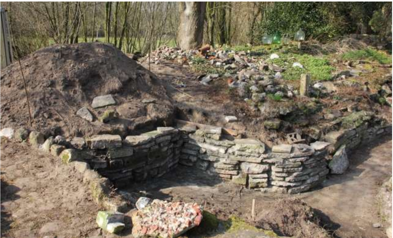
Renovatie van de oude Puintuin in volle gang, nu met cement tussen de stenen (maart 2017).
