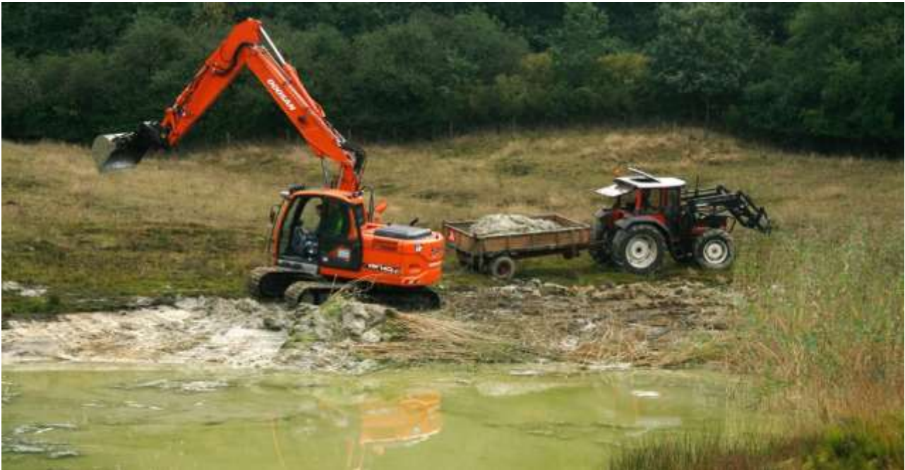
Het Riet wordt met wortel en al machinaal uit het Kristalmeer verwijderd (oktober 2009).
