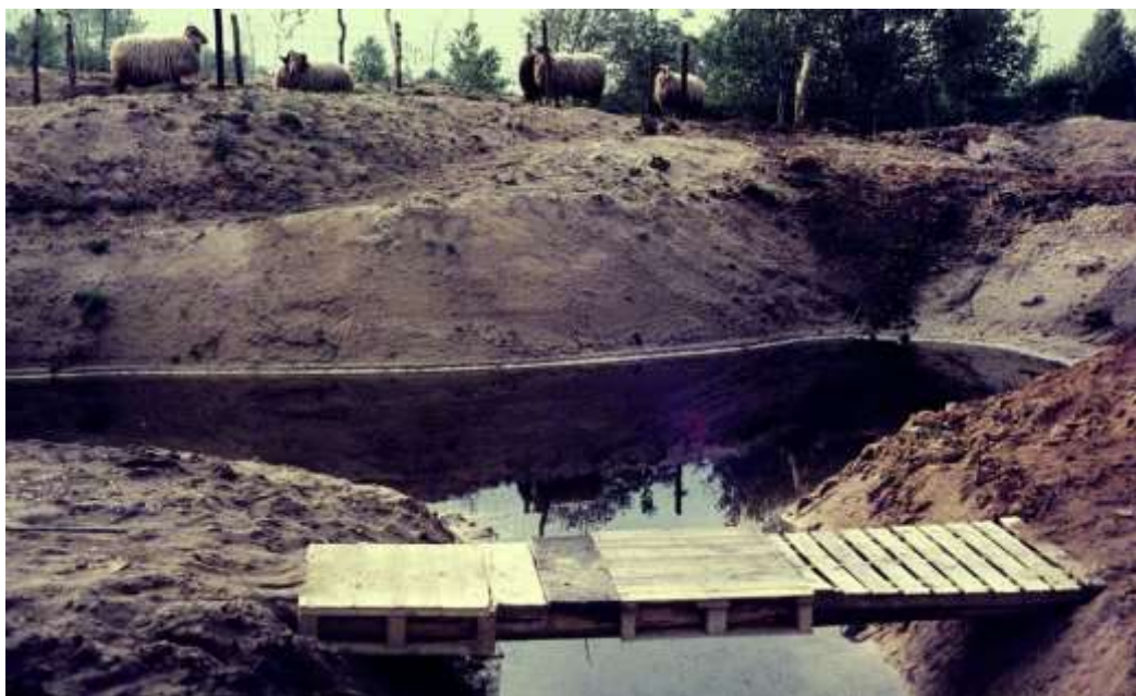
De Lelievijver direct na het uitgraven, nog zonder vijverfolie, met een provisorisch bruggetje van pallets. De steile oevertaluds en het diepe grondwater vallen op (mei 1983).
