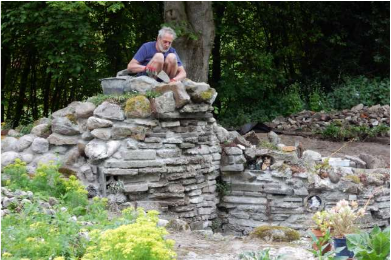
Metselend aan de Watertoren (mei 2017).
