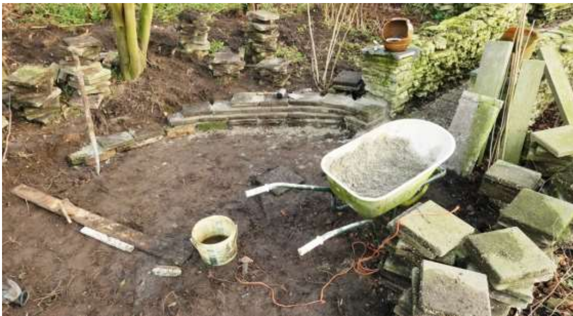
De eerste vorderingen bij het metselen aan de Kiva (januari 2022).
