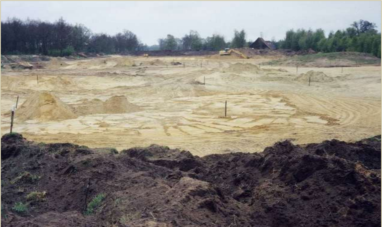
De eerste fase van de graafwerkzaamheden. De bemeste, humeuze bovengrond is rondom op wallen gedeponeerd (voorground) en het bruikbare zand is grotendeels afgevoerd (mei 1991).
